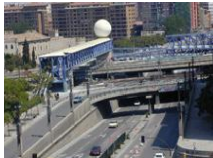
Desmontaje paso a desnivel
