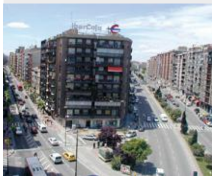
Cruce Avda. Madrid - Avda. Navarra
