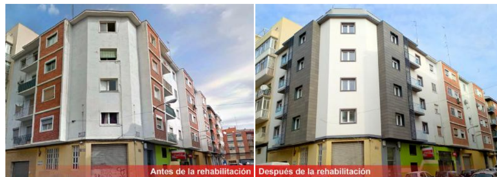
Antes de la rehabilitación Después de la rehabilitación
