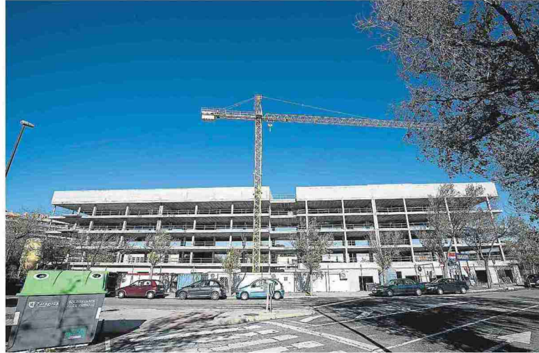
Estado de las obras del edificio, ubicado entre María de Aragón y Fray Luis Urbano, ayer. OLIVER DUCH
